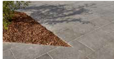
Våd lægning med cement
