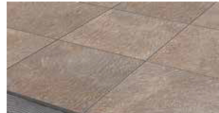
Lægning på støbt underlag med fuger
